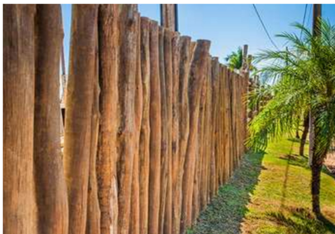
Imagem 11 – Cerca em madeira eucalipto, conforme ficha de especificação SINAPI.
