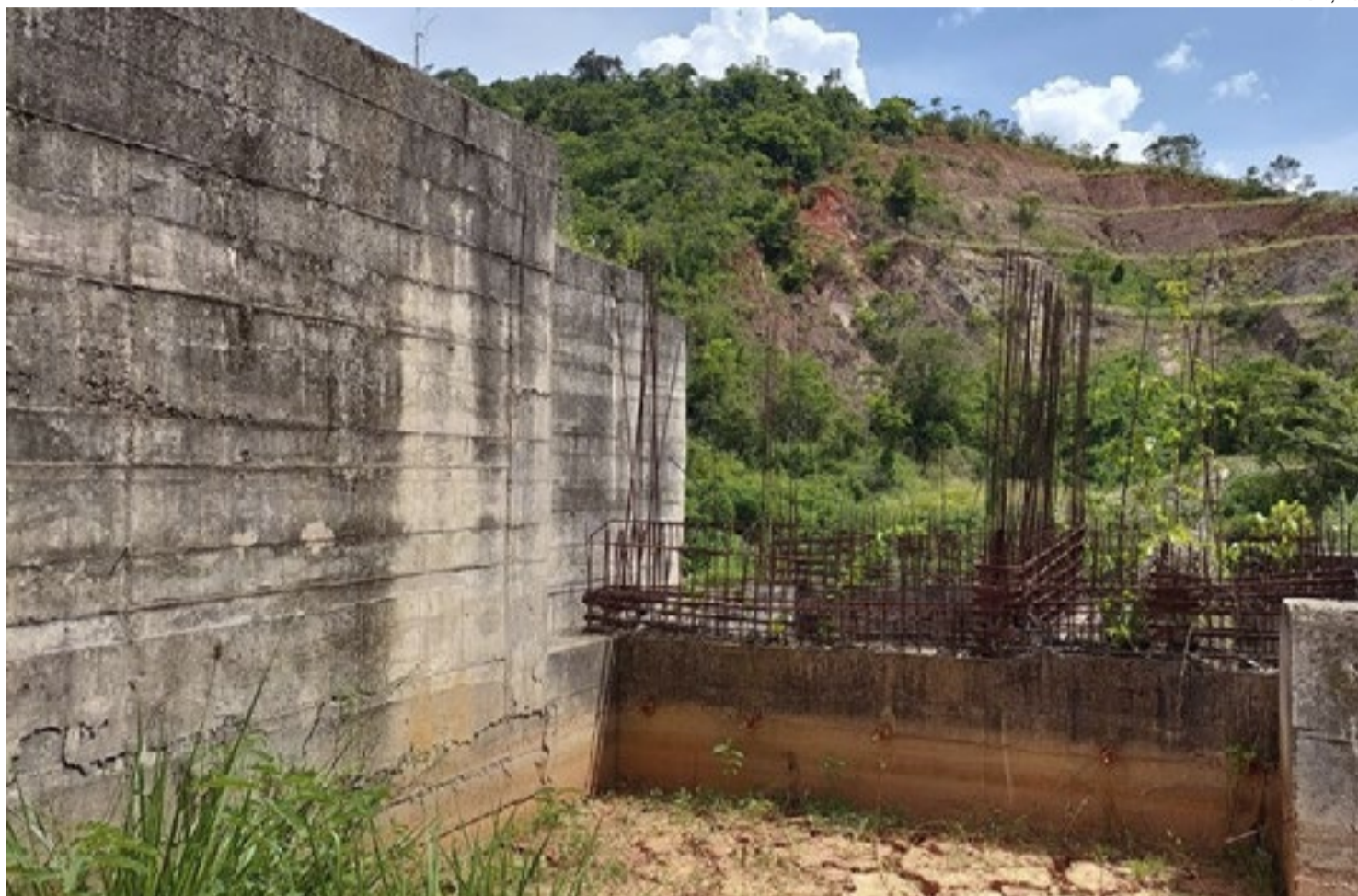
Barragem de Gatos foi interrompida com 20% de suas obras executadas
