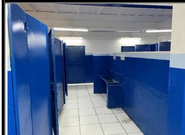
Imagem 03: 12 portas de ferro, divisória de concreto pré-moldado
