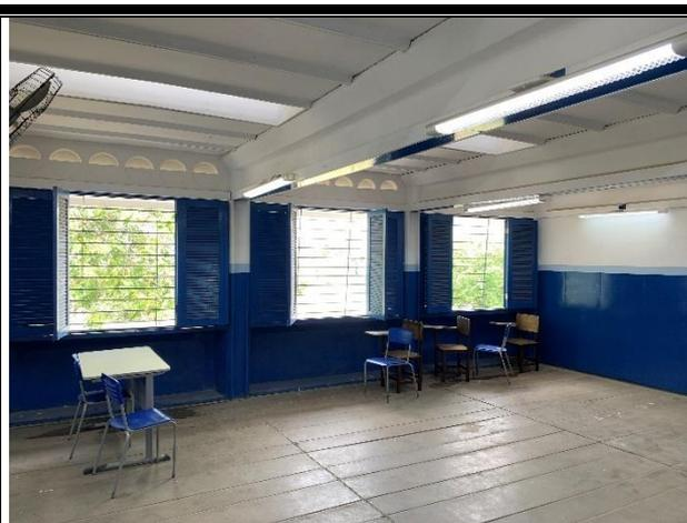
Imagem 02: Parede com 3 janelas de madeira e 3 grades de ferro
