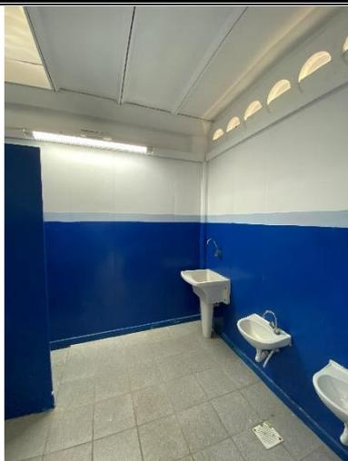
Imagem 01: 2 pias, 1 lavatório com coluna, 1 ralo, piso em cerâmica.
