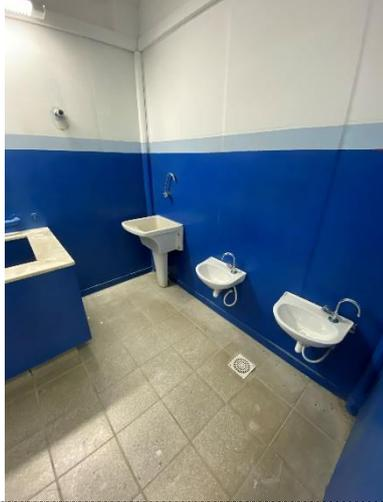
Imagem 01: 2 pias, 1 lavatório com coluna, 1 ralo, piso em cerâmica.
