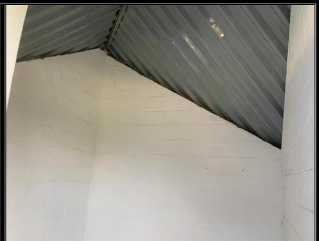
Imagem 02: Teto de telha metálica
