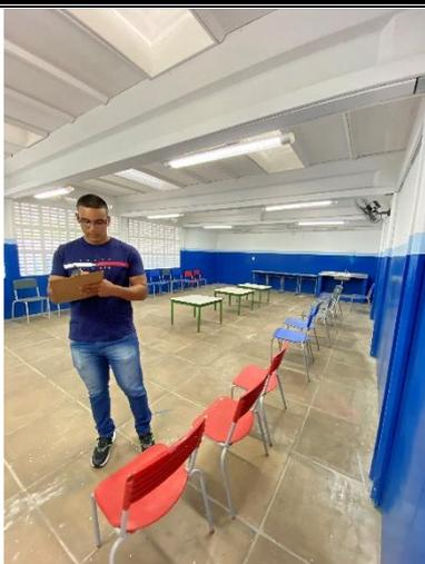
Imagem 01: piso em placas de concreto, paredes OK.
