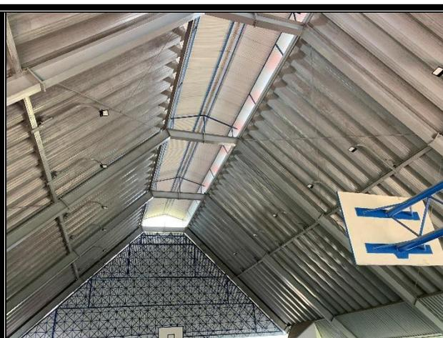
Imagem 02: Teto da quadra de telha metálica
