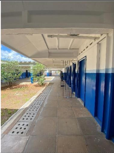
Imagem 01: passeio em placas de concreto, drenagem pluvial.
