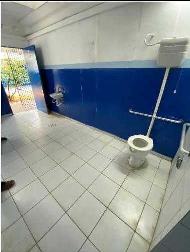
Imagem 03: vaso sanitário (faltando a tampa), 1 pia, 1 ralo, piso cerâmico, paredes OK.
