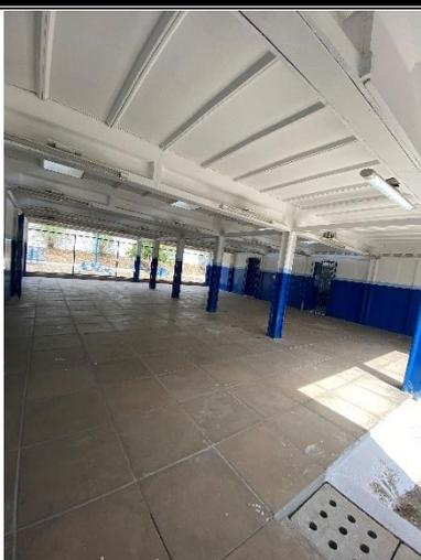
Imagem 03: 39 luminárias duplas, piso em placas de concreto, 9 pilares.
