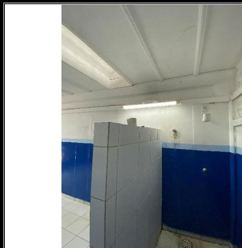
Imagem 04: Divisória revestida em cerâmica 1,85 altura.
