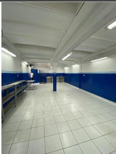
Imagem 03: 12 luminárias duplas, revestimento em cerâmica do piso OK, porta de madeira.
