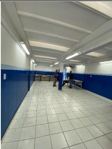
Imagem 03: 12 luminárias duplas, revestimento em cerâmica do piso OK.
