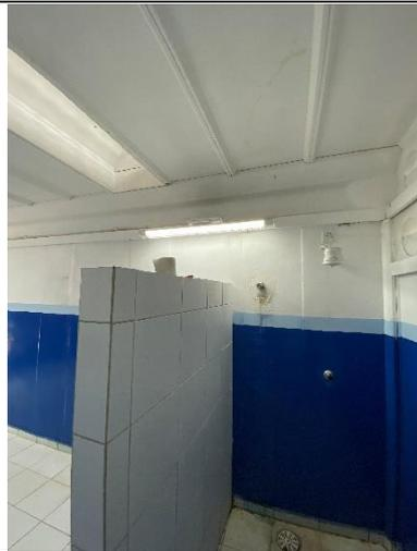
Imagem 04: Divisória revestida em cerâmica 1,85 altura.
