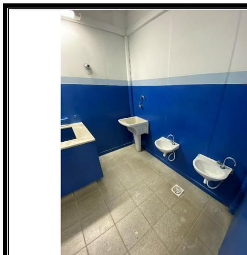
Imagem 01: 2 pias, 1 lavatório com coluna, 1 ralo, piso em cerâmica.
