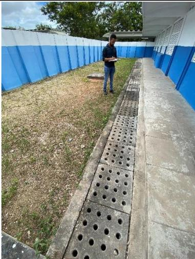
Imagem 03: Drenagem pluvial (20,00 x 0,50)
